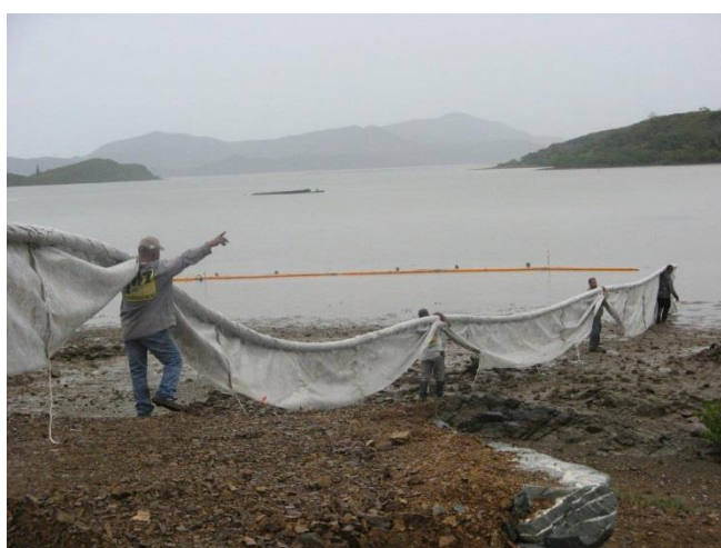
Réalisation du barrage anti-pollution
