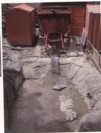
Bassin de collecte des laitances de béton
