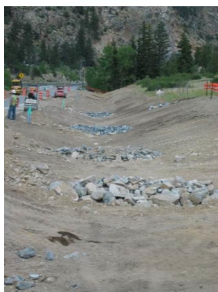
Fossé à cloisonnement ballast - ouvrage type
