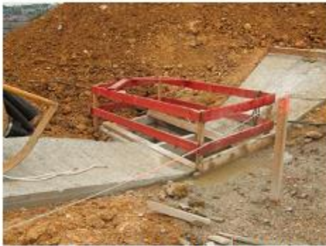
Bassin de collecte des laitances de béton
